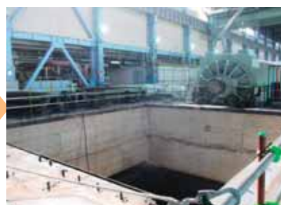
低圧タービンロータ撤去後
