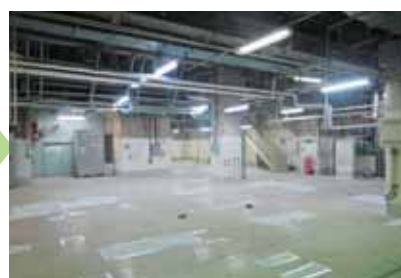
タービン熱交換器撤去後
