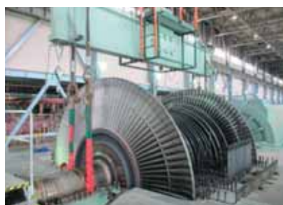
低圧タービンロータ撤去前
