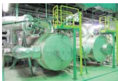
タービン熱交換器撤去前
